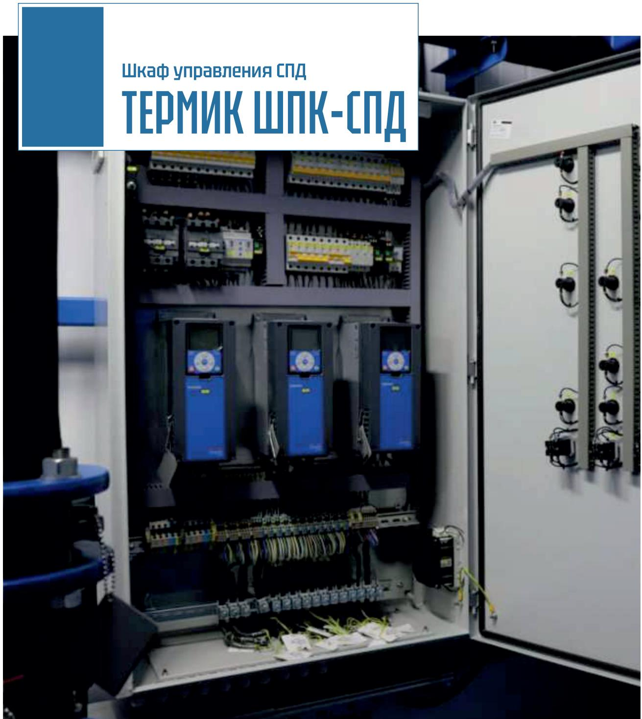
«Термик ШПК-СПД» предназначен для электропитания и автоматического управления насосным оборудованием станции повышения давления с целью поддержания заданных параметров давления в водопроводной сети. Использование частотных преобразователей позволяет осуществлять мягкий пуск электродвигателей насосов и плавно изменять их напорную характеристику при увеличении/уменьшении расхода, а также экономить электрическую энергию.
