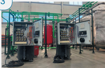
3. Электрические котлы ТЭНовые промышленные
