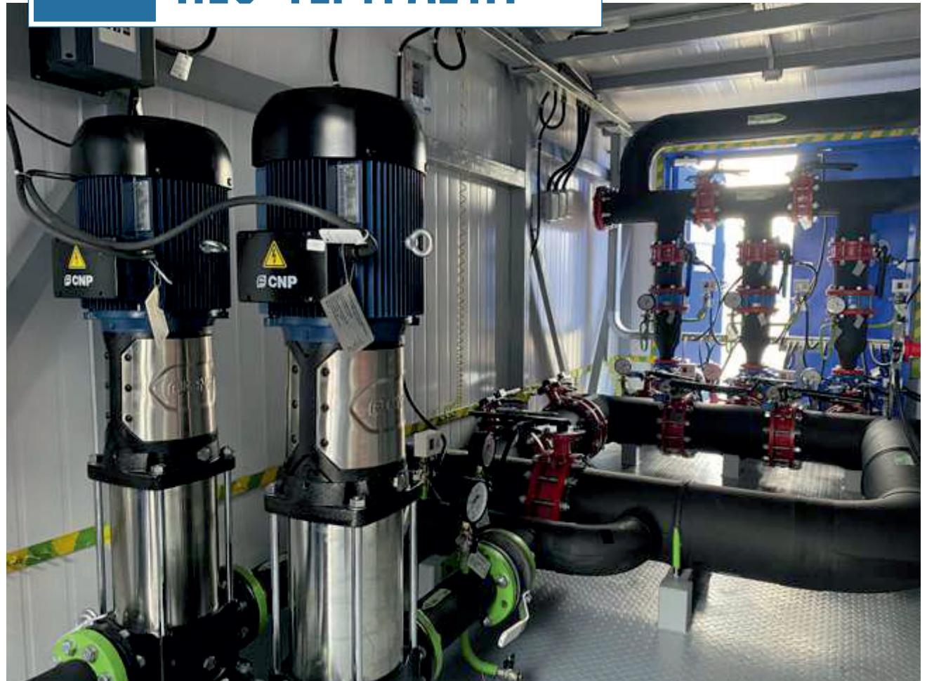
Блок-бокс представляет собой две группы насосных агрегатов для производственного и для противопожарного водоснабжения (наружное и внутреннее водяное пожаротушение зданий и сооружений на площадке).
