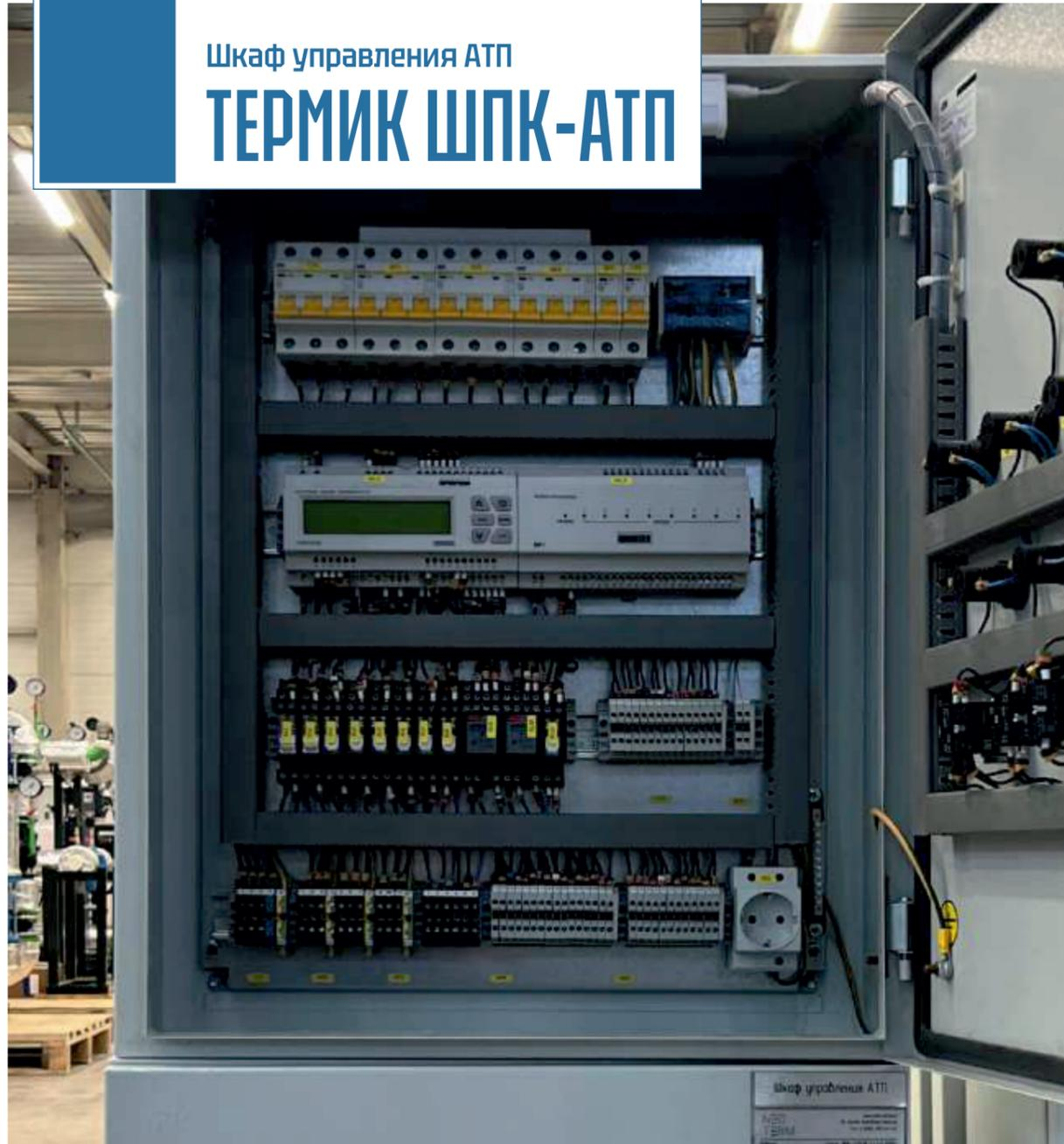
«Термик ШПК-АТП» предназначен для электропитания и автоматического управления оборудованием тепловых пунктов, работающих в системах теплоснабжения жилых, общественных и производственных зданий, и автоматического регулирования параметров теплоносителя в системах отопления и ГВС.
